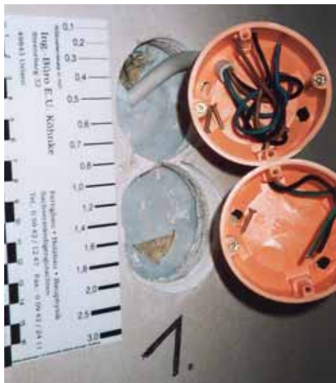
Abb. 3: Einbau der Elektroninstallationsdosen.
